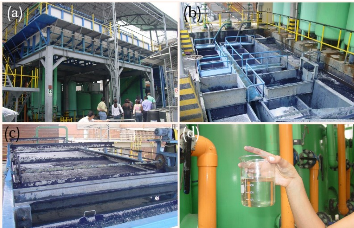
Figura 5 – Fábrica de Jeans Medellín, Bogotá, Colômbia. (a) Unidade Principal de Tratamento (b) Decantador (c) Flotador (d) Efluente final (fotos do autor)
