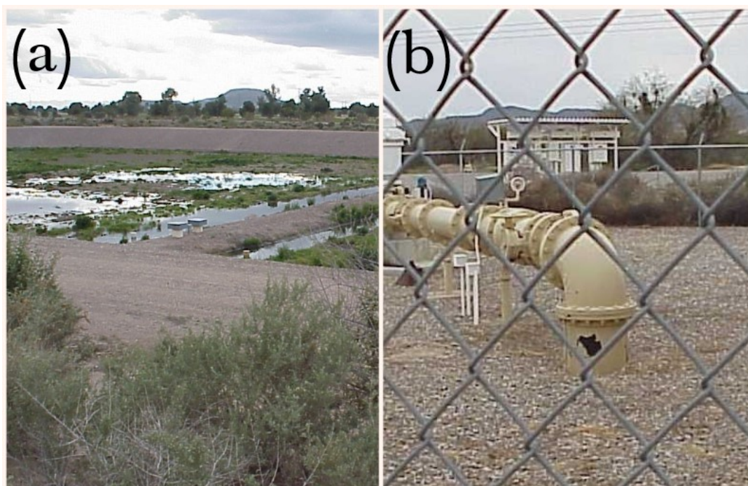
Figura 7 – (a) Lagoas de Infiltração (b) poço de extração, Sweetwater Facility, Tucson, Arizona, EUA. (fotos do autor)
